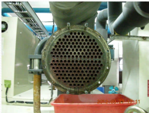
180RT x 4 冰機冷凝器銅管
