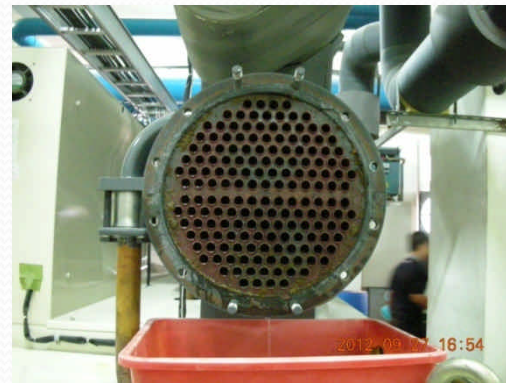
180RT x 4 冰機冷凝器銅管
