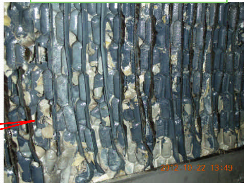
500RT x 2冷卻水塔鰭片水垢
